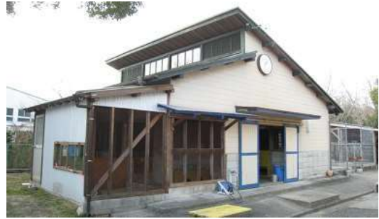
動物棟の増築
