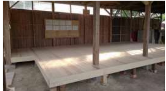
ピザ窯建屋に板張り（725cm×372cm）新設
