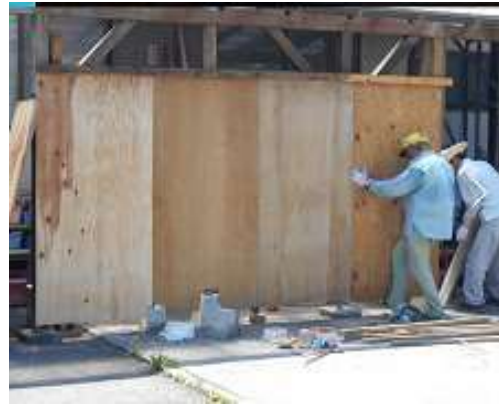
薪置き場の壁の取替
