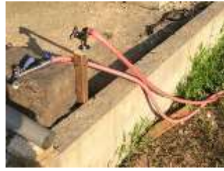
農楽堂の水道の新設
