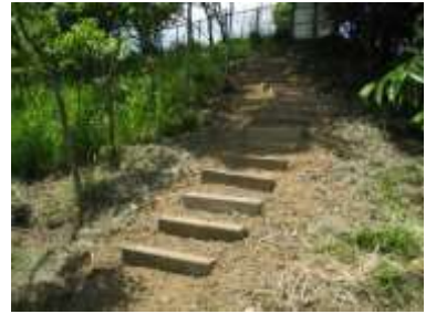
南法面の階段の新設
