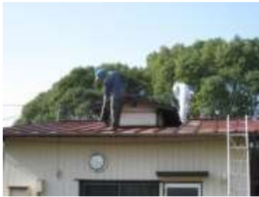
管理棟の屋根・壁の塗装
