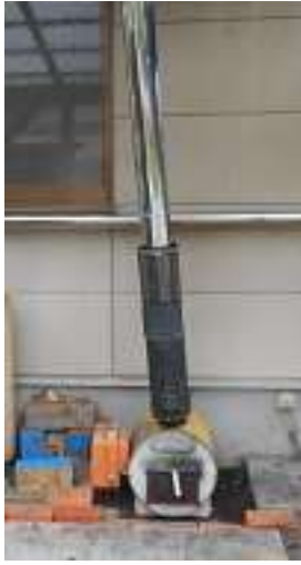
ボイラー釜・煙突の取替
